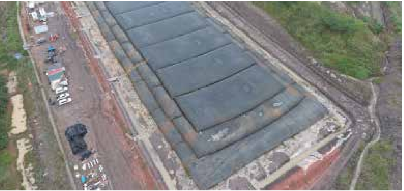
Pengelolaan lumpur tambang menggunakan teknologi Geotube
